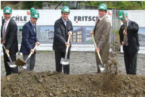
Foto mit Wiederholungseffekt: Beginn von Bauarbeiten
